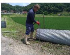
電気柵の設置
