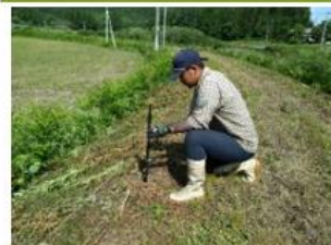
侵入防止の電気柵設置作業
